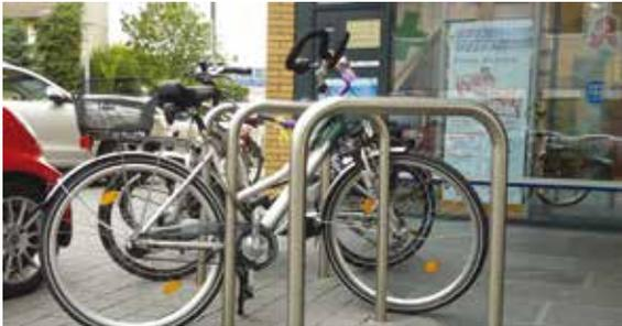
**Absperr- und Fahrrad-Anlehnbügel** aus EDELSTAHL, Korn 240 geschliffen
