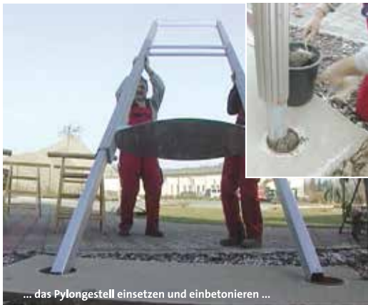
... das Pylongestell einsetzen und einbetonieren ...
